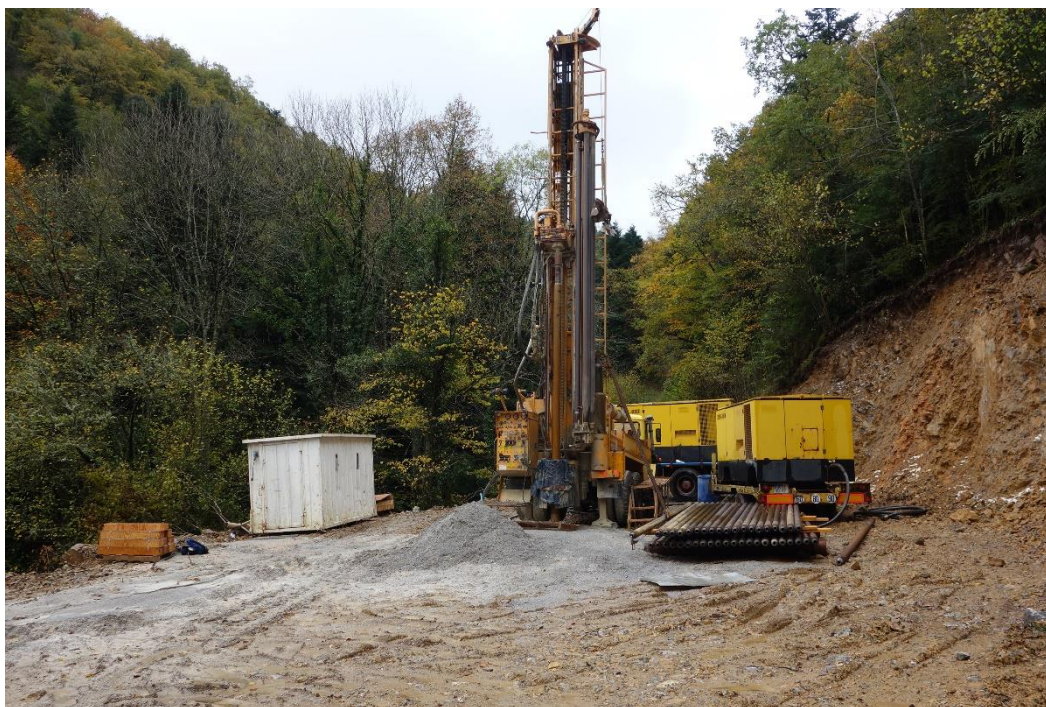
Machine de forage (méthode du marteau fond de trou) au Blau
